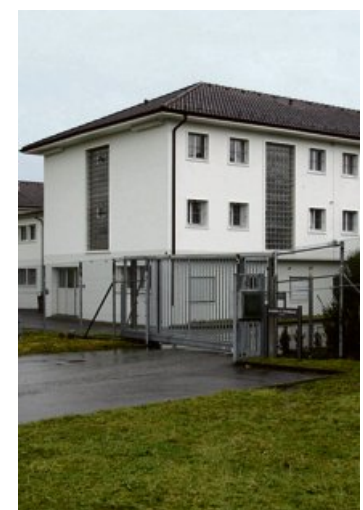
Das Frauengefängnis muss saniert werden. Foto: Andreas Marbot
