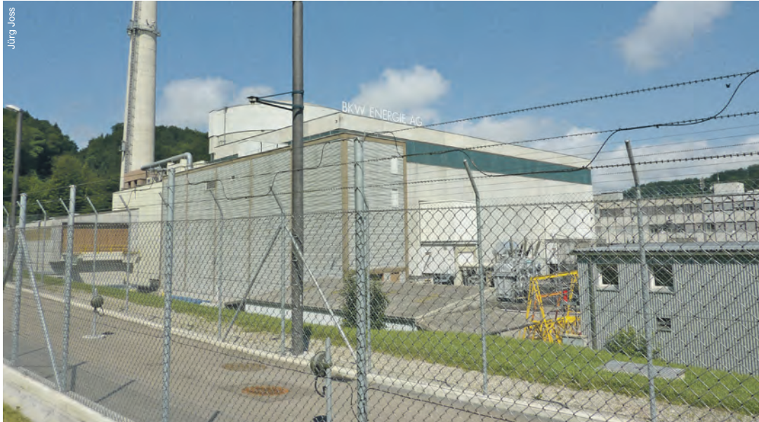
Das AKW Mühleberg ist veraltet und genügt den elementarsten Sicherheitsanforderungen nicht mehr.
