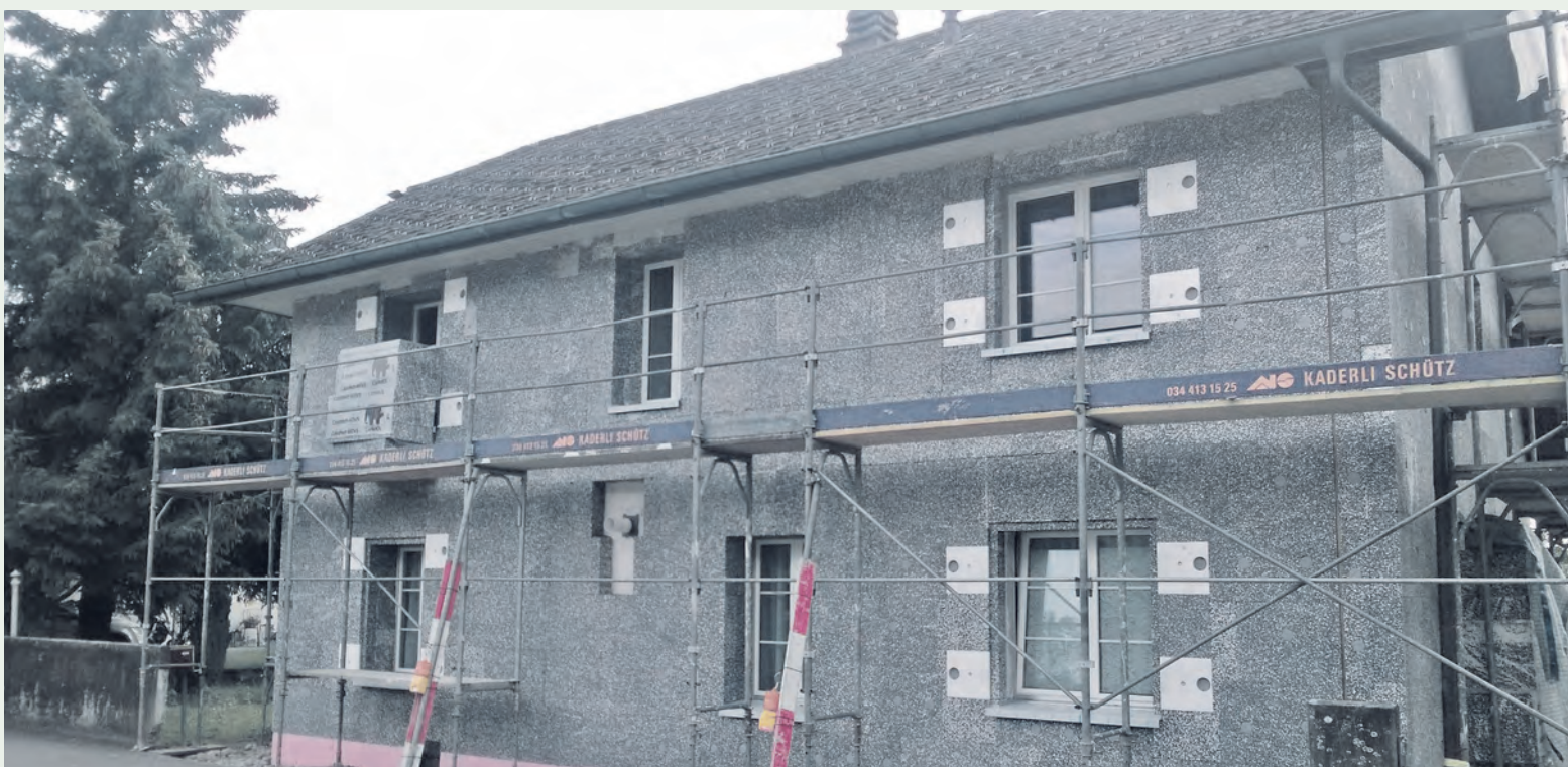
Energiepolitik ist nicht nur Strompolitik: Wärmesanieung bei einem Altbau.
