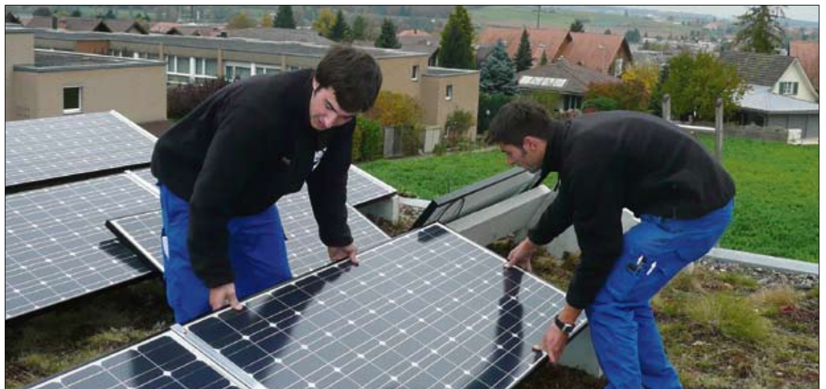
Mitarbeiter des Solarcenter Muntwyler montieren die Solaranlage bei Gutknechts.
